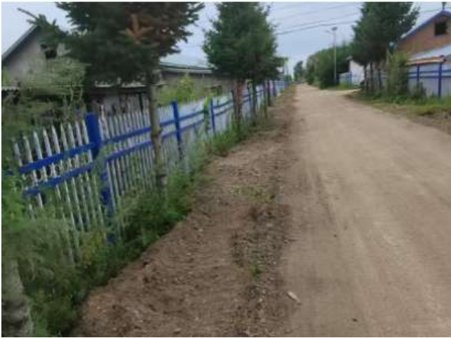
输配水工程区（农村道路恢复）
