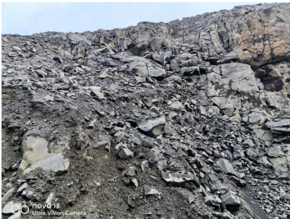
图 3-11 三采区开采崩落堆积的危岩体 近景
