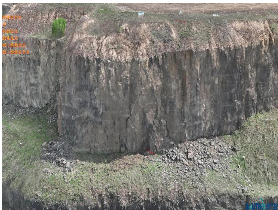
图 3-8 一采区高陡边坡及底部倒石堆
