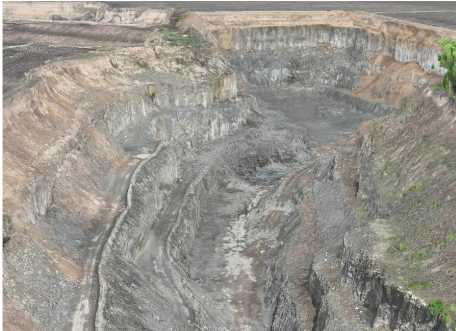
图 3-5 三采区无人机三维模型（近景）
