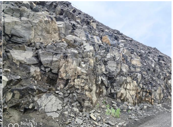
图 3-12 三采区边坡近景
