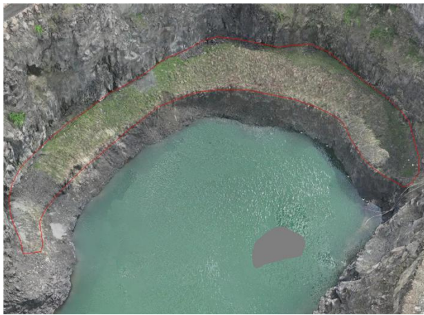
图 5-3 南侧 III 级平台
