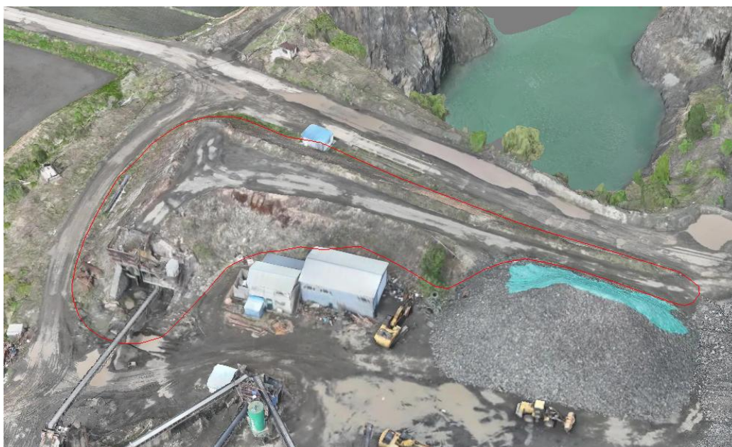
图 5-1 工业广场投料平台
