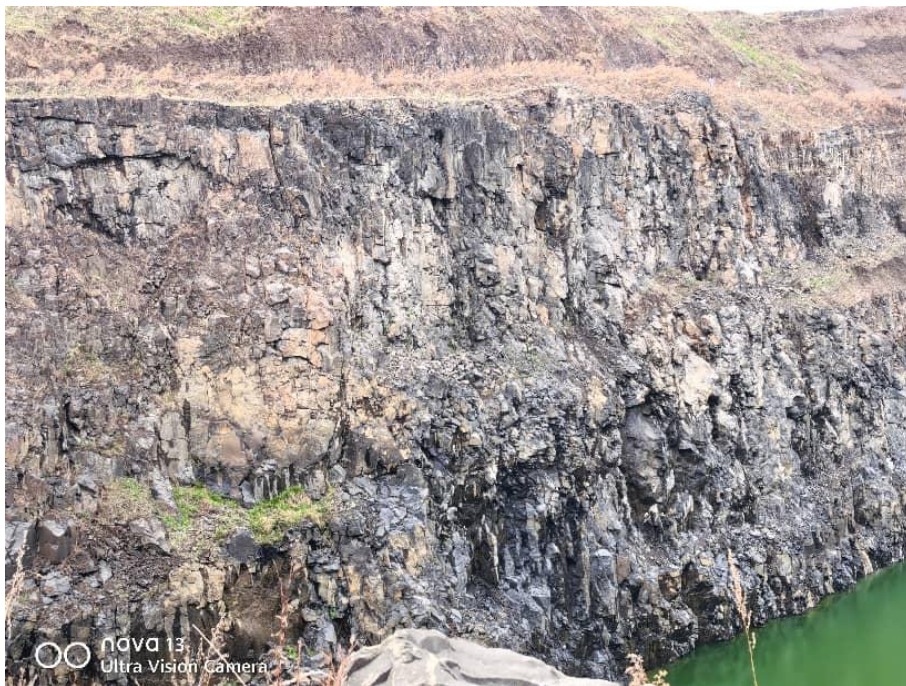
照片 3-5 下部局部较为破碎危岩体
