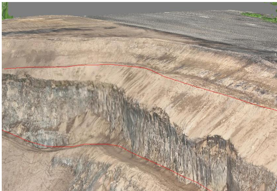
照片 3-3 二级边坡
