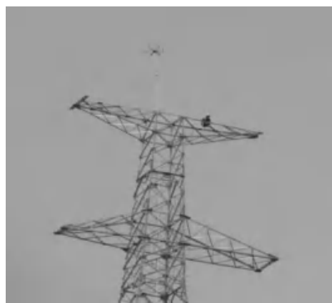
图 2-7 多旋翼无人机放线
