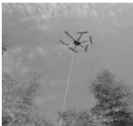
图 2-7 多旋翼无人机放线
