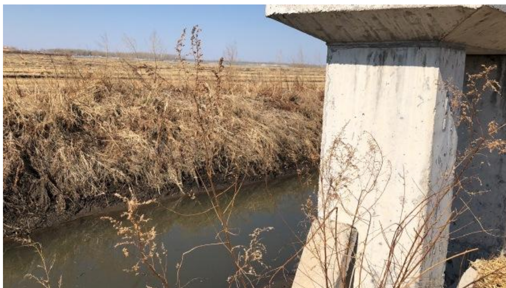
图 2.1-3 柳河干渠工程现状照片
