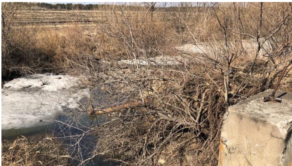
图 2.1-4 柳河干渠建筑物工程现状照片
