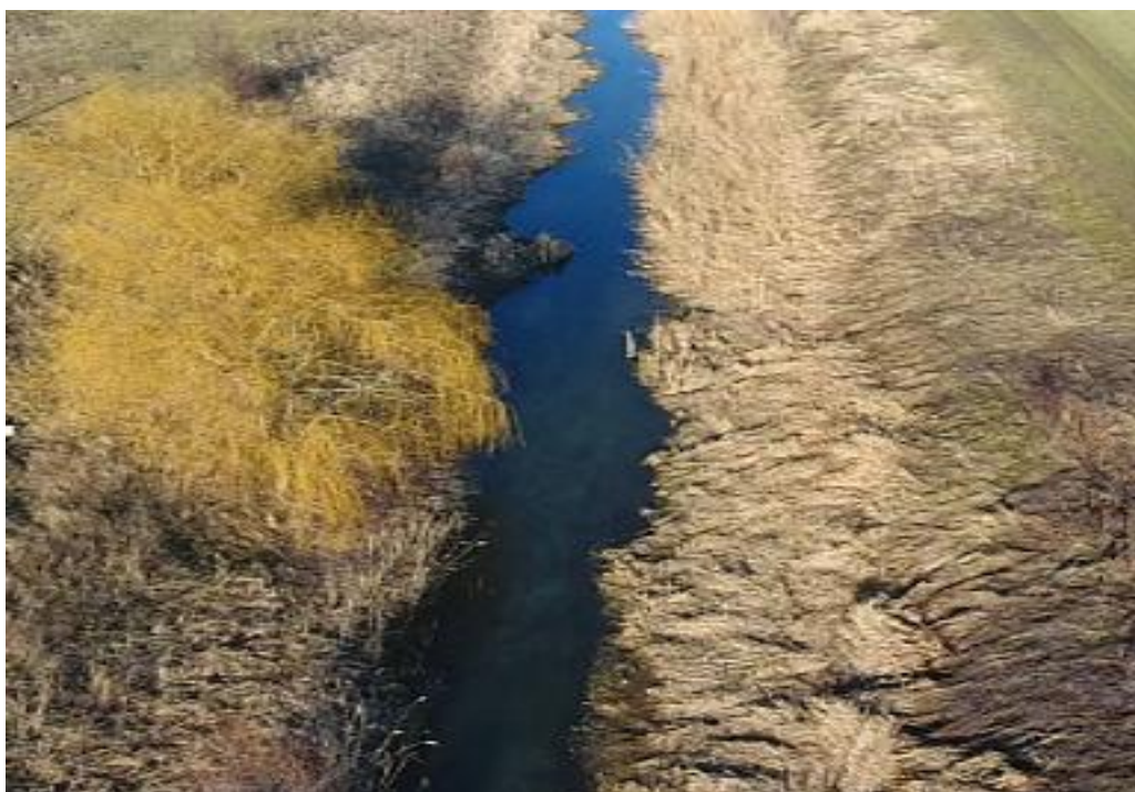
图 2.1-5 排水沟道工程现状照片
